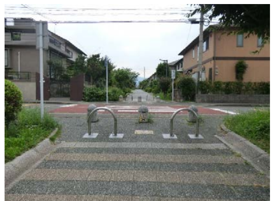
▲舗装・車止め・街路樹の一体的な整備事例 (舞の里団地)
