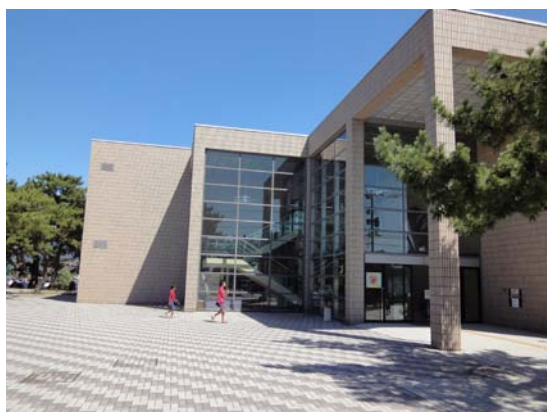
分節化による建物壁面の変化
