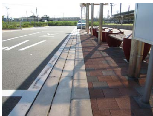
歩道と車道の段差解消
