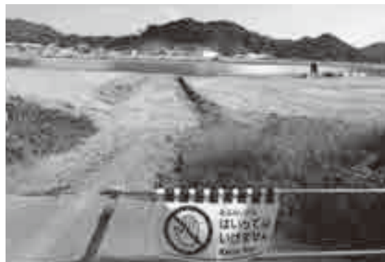
工事が進む篠林物流団地
