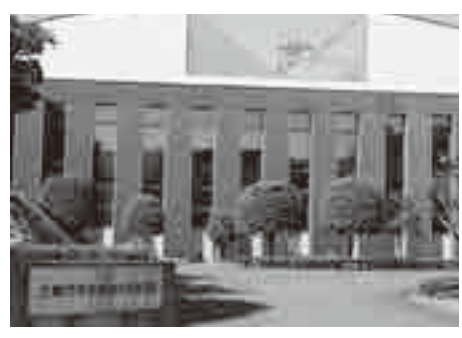
老朽化対策は自治体の課題（給食センター）
