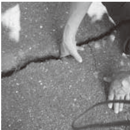
今の庄石ヶ崎橋付近の歩いてん道の亀裂
