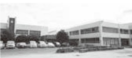
外壁改修工事が終わりがきれいになった花鶴小学校
