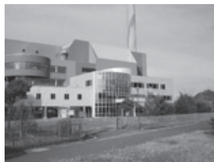
古賀清掃工場に常時監視装置の設置
