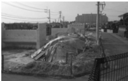
立体交差工事が進む浜大塚線鹿部踏切
