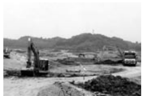
工事が進む小野南部基盤整備事業
