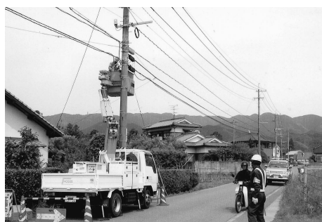
山間部でも進む光回線工事（小野地区）
