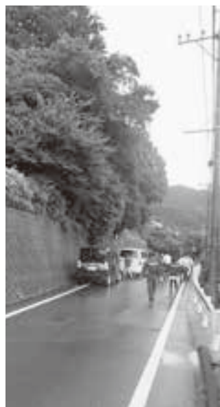
急傾斜地危険区域の現地視察
