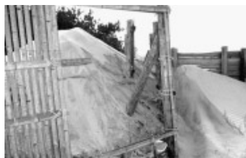
砂防柵の内側まで堆積した砂
