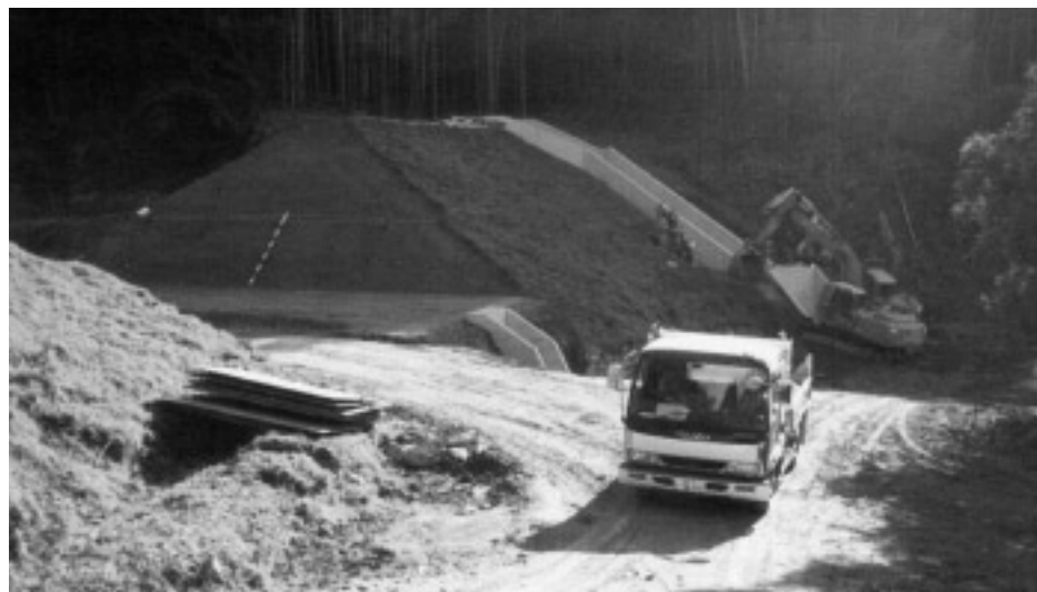
寺浦ため池工事がすすむ（小山田区）
