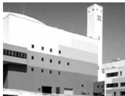
環境に配慮した街づくりに貢献
