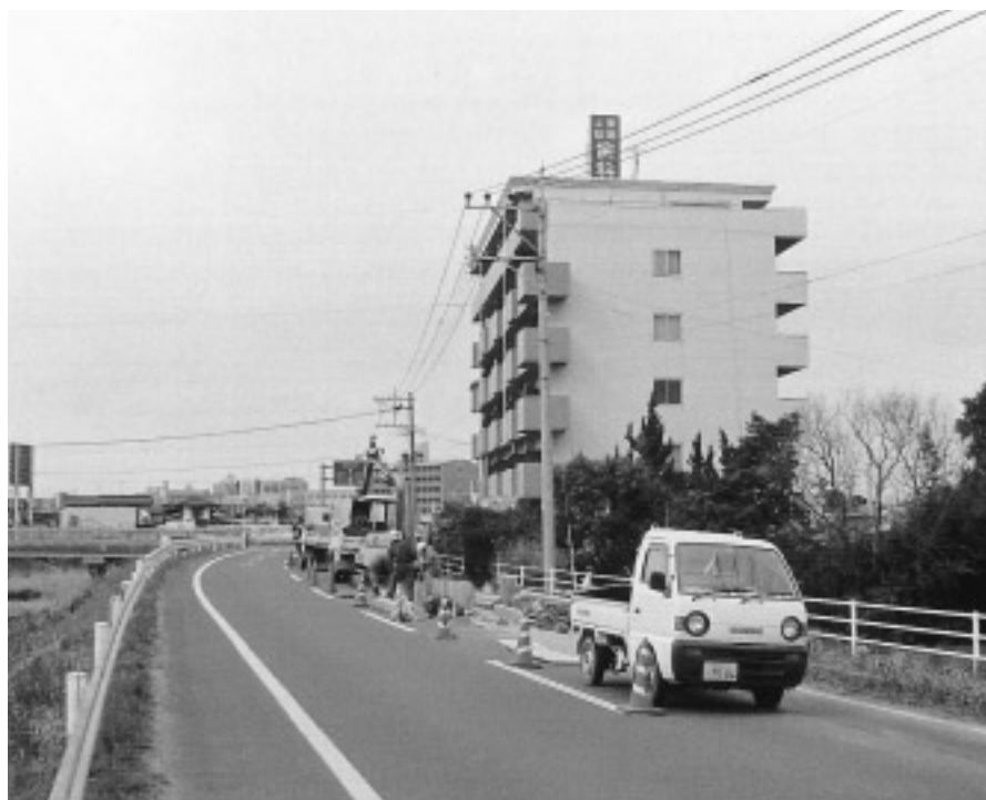
公共下水道工事現場（久保大根川そば）
