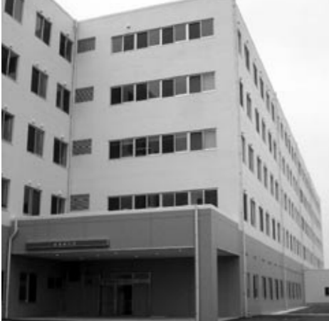
新築された福岡東医療センター病棟
