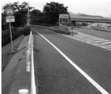
九州自動車道古賀インター
